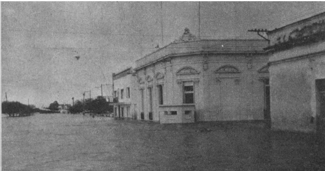
Figura 8: Edificio de Prefectura Gualeguaychú durante la inundación de 1978.
