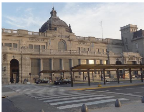
Estación Retiro. (Transporte)
