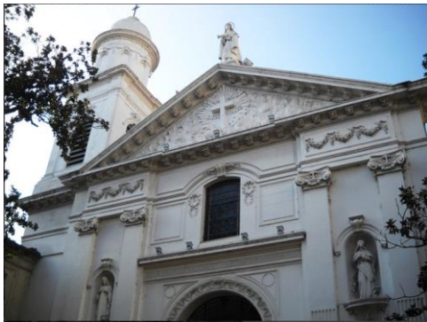
Convento Santa Catalina - Fachada
