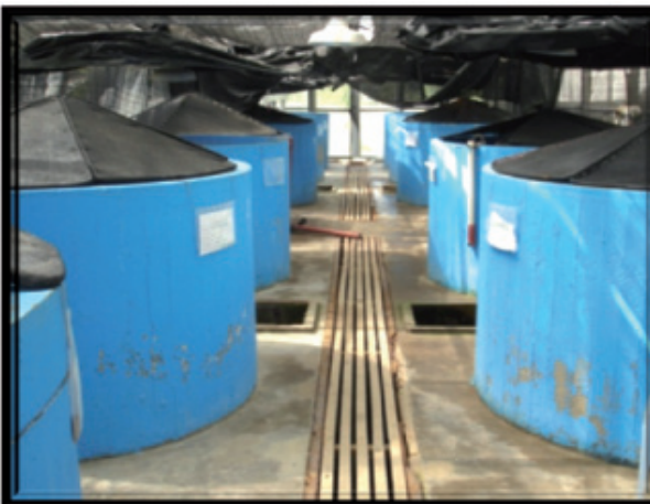
d) Tanques internos de 3000 lts.
