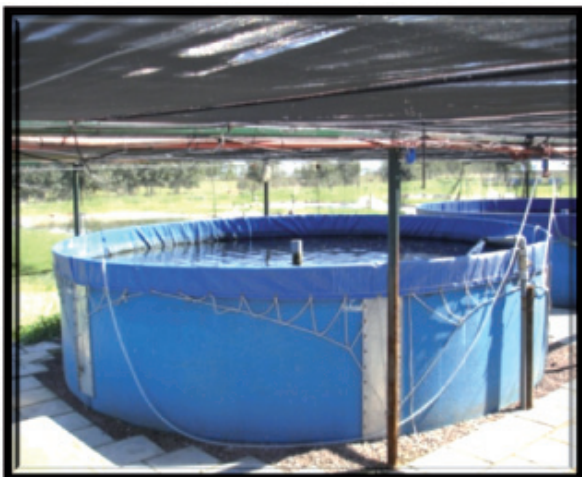
a) Tanques externos de 25.000 lts
