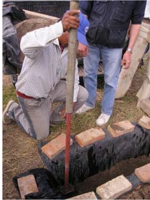
Foto 8.4.d: Fase de compactación por medio de un pisón metálico
