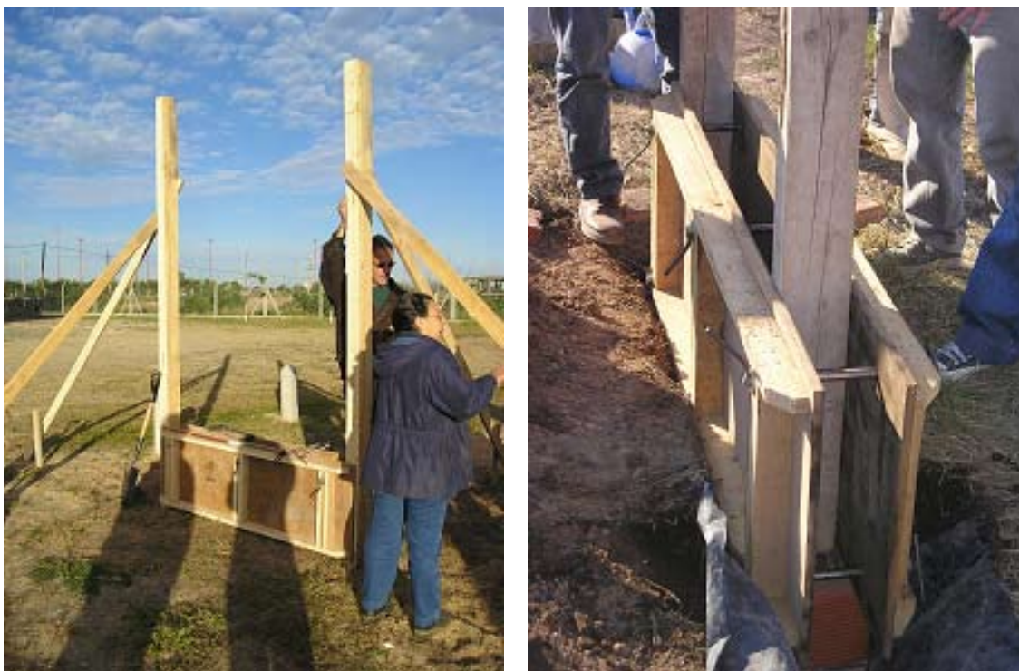
Foto 8.4.a – 8.4.b: Encofrado con las guías verticales y separadores transversales
