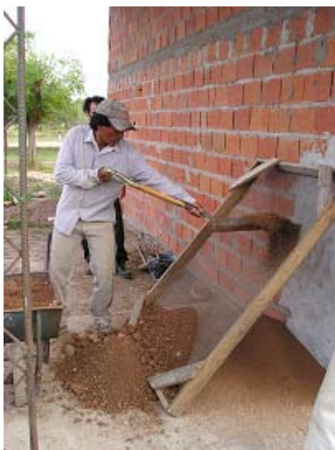
Foto 8.1.a: Fase de tamizado de la tierra
