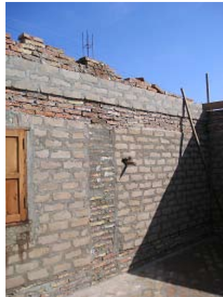
Foto 10.3.r: Alternarse de BTC y ladrillos
