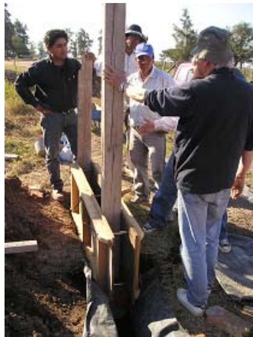
Foto 8.4.g: Colocación de las guías verticales
