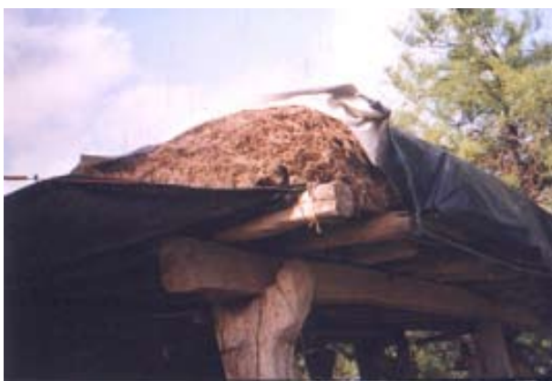
Foto 6.1.i e 6.1.j: Particular d techo de tierra (“torta de barro”) 33
