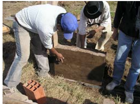
Foto 8.4.l: Prototipo de tapia estabilizada con yeso
