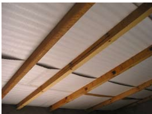
Foto 10.3.e: Polietileno espumado
