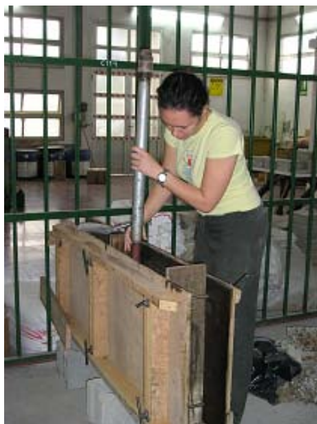
Foto 8.4.q: Realización de la tapia con cemento y cal
