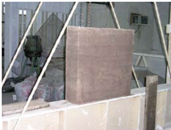
Foto 8.4.t: Grietas en la tapia estabilizada con yeso y gluten
