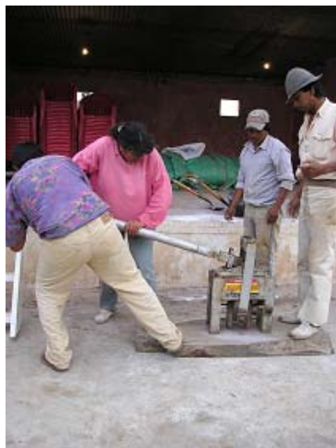
Foto 8.1.g: Compactación de la mezcla de tierra
