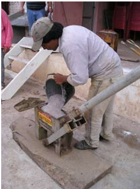
Foto 8.1.f: La mezcla se coloca en el interior del molde
