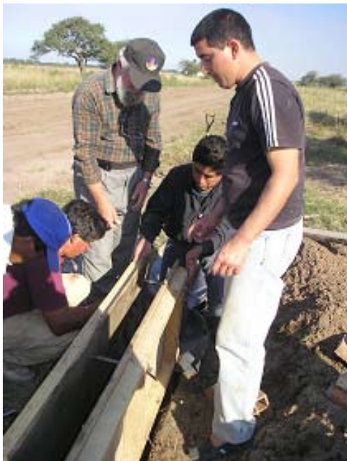
Foto 8.4.f: Posicionamiento de los encofrados para la construcción de la pared
