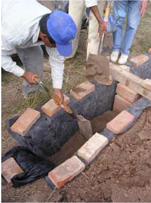
Foto 8.4.c: Primer capa de mezcla al interior de la excavación
