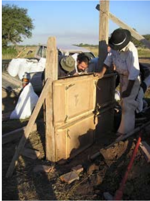
Foto 8.4.h: Montaje del segundo encofrado
