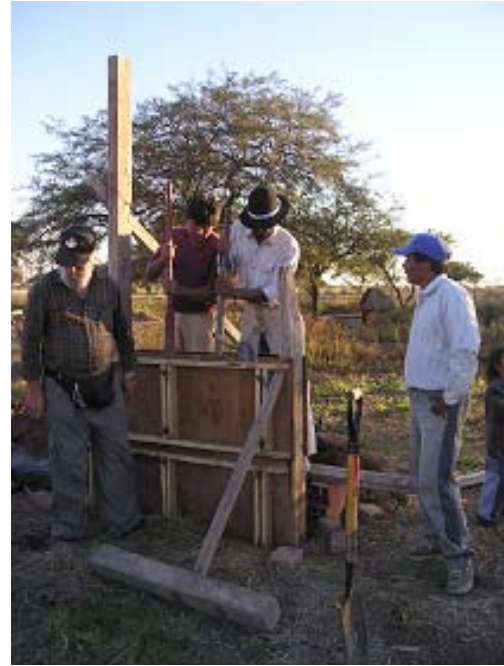
Foto 8.4.i: Compactación de la tapia
