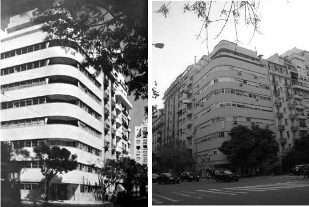
Fig. 3-4. Vivienda colectiva en Callao y Alvear / Collective dwelling in Callao and Alvear street (Daniel Duggan, 1937) Estado original y vista actual que muestra transformaciones e intervenciones inapropiadas que afectan su estética Original state and current view that show inappropriate transformations and interventions that affect their aesthetics Foto original/ Original Photo: Revista Nuestra Arquitectura. Buenos Aires, Ene., 1937 Estado actual/ Current state: Carolina Quiroga, 2007
