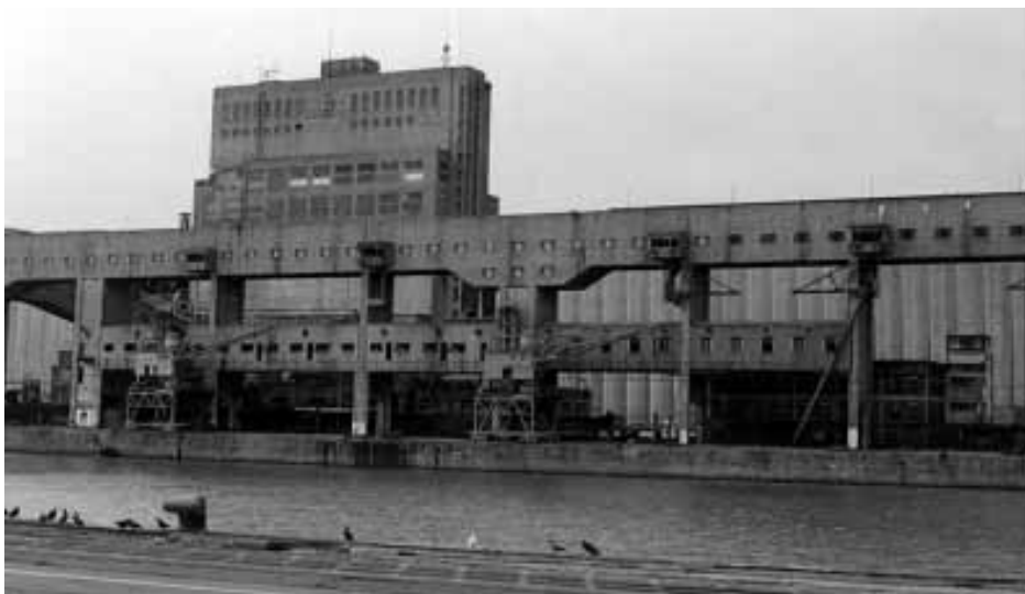
Fig. 3. Silos de la ex Junta Nacional de Granos, Dársena D, Puerto Nuevo, estado actual (Foto: Stella Maris Casal) Former Junta Nacional de Granos grain elevators, current state (Photo: Stella Maris Casal)
