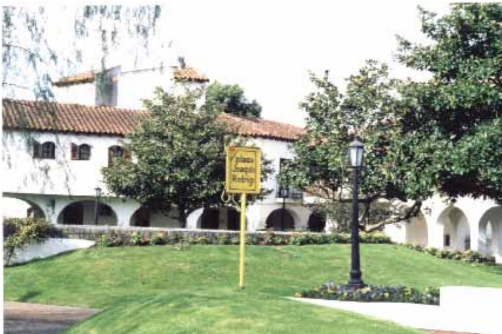
La imagen general se define a partir de una arquitectura de muros blancos, cubiertas de tejas, galerías perimetrales y una muy cuidada parquización.
