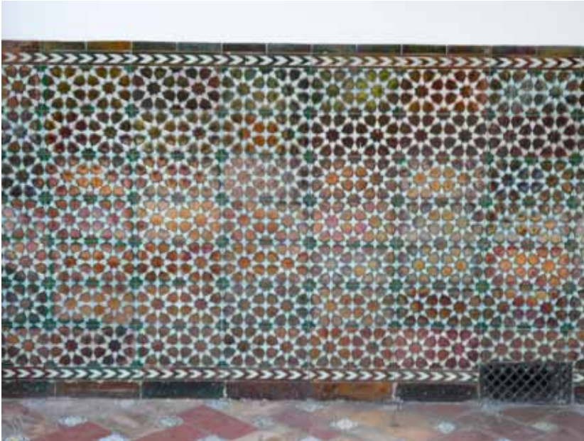
Zócalos altos de azulejo enfatizan el carácter general del edificio.
