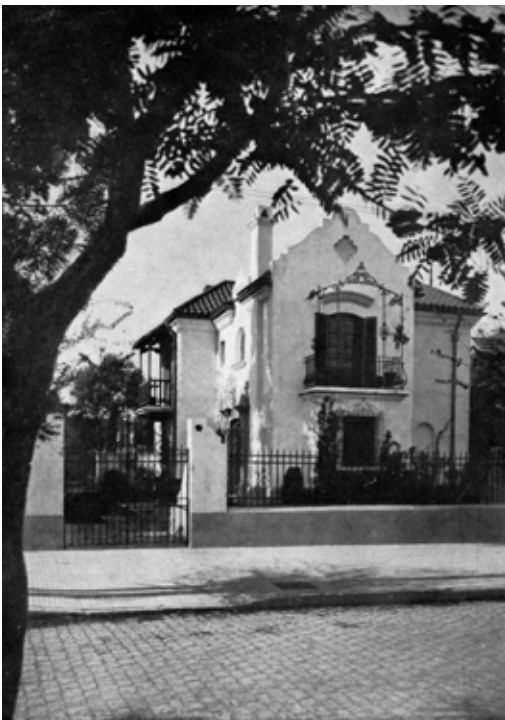
Casa para el Sr. César Vallejo en Ayacucho 130, San Martín, provincia de Buenos Aires.
