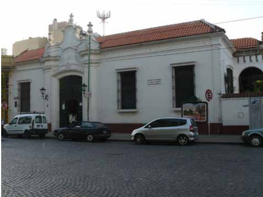
Fachada exterior sobre Av. Juramento.
