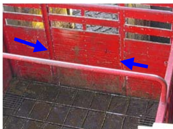
Foto 23: acop. camión mixto sin rodillos interno
