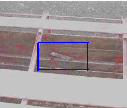
Foto 18: planchuela doblada en el interior
