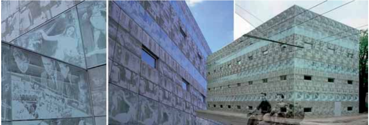
Foto: Biblioteca de la Escuela Técnica Superior en Eberswalde. Herzog & de Meuron.
