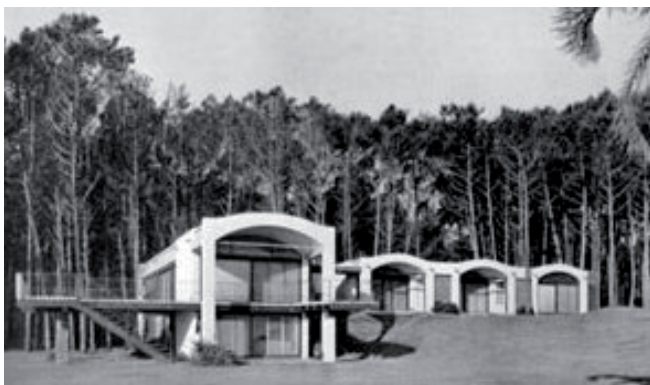
Casa Berlingieri. El ritmo y la modulación que imponen las bóvedas catalanas ordenan la distribución y definen el carácter espacial de la vivienda. Foto izquierda en Hitchcock, Henry-Russell . Latin american architecture since 1945 , p.163. Planta, tal como aparece en www.hotelterrazadelmar.com
