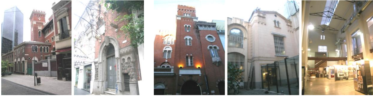
Estaciones eléctricas CIAE
