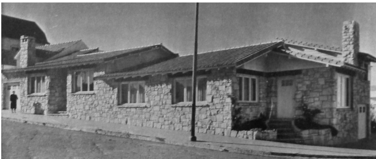
Fig.5: Casas en Mar del Plata / Houses in Mar del Plata (Foto / Photo: Revista Nuestra Arquitectura #5 1946 / Nuestra Arquitectura magazine #5 1946)
