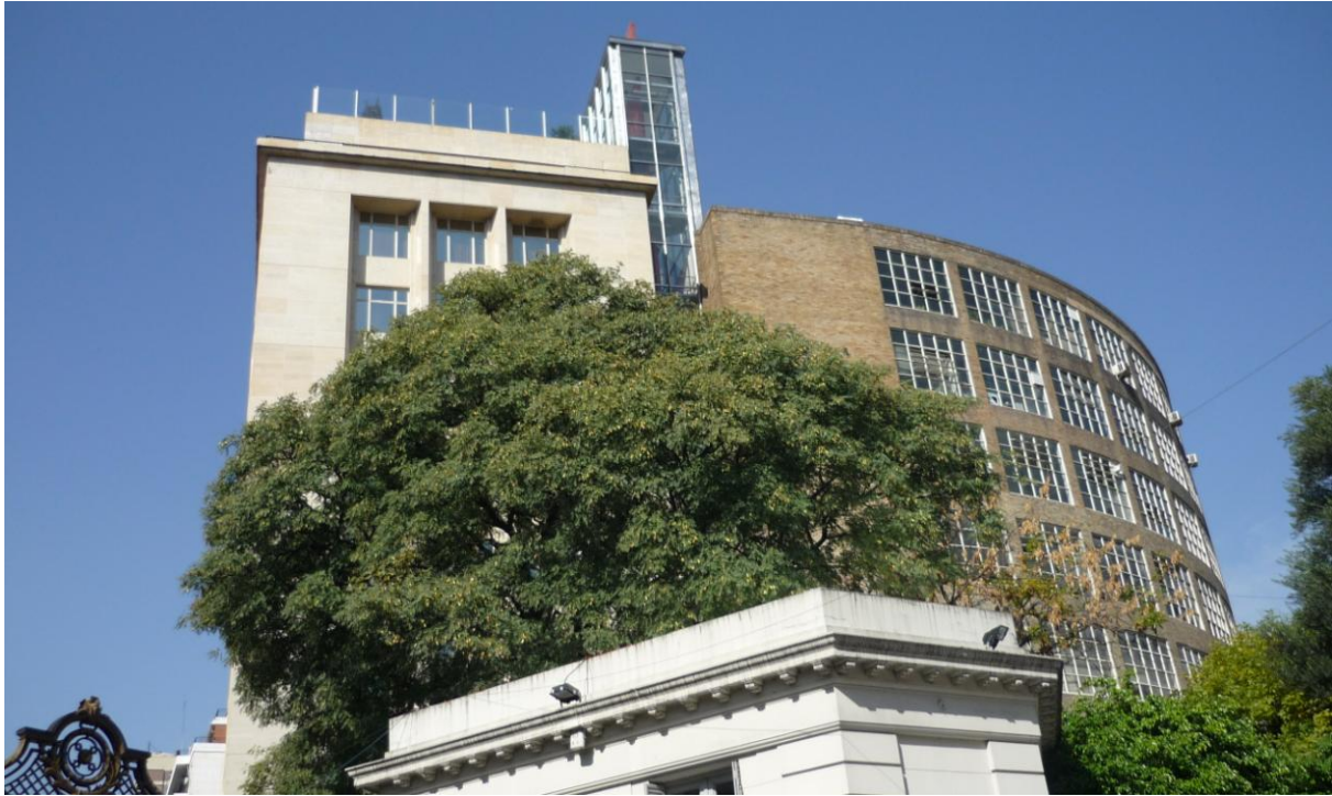
Fig. 5-6. Sede Central del Automóvil Club Argentino –intervención estudio ASZ / Automóvil Club Argentino headquarters – ASZ intervention. (Fotos / photos: Stella Maris Casal)
