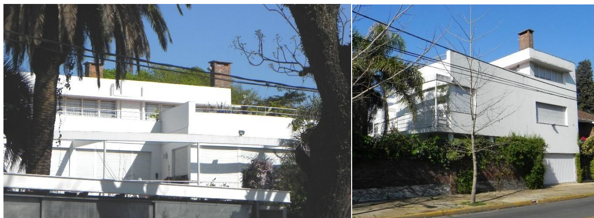
Fig. 3,4. Casa Vilar – San Isidro / Vilar House – San Isidro. Foto / Photo: Fernando Couturier 2015
