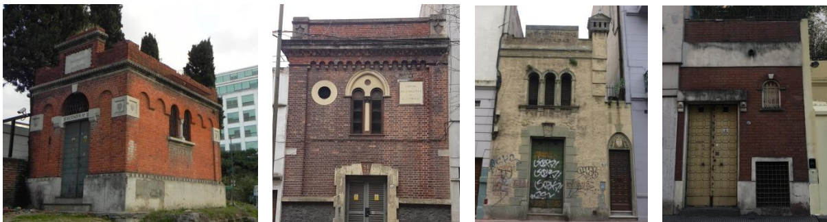
Fig. 6, 7, 8, 9: Subestación Av. de los Italianos 385, Subestación José A. Salmún Feijóo 762, Subestación Brasil 539, Subestación Uspallata 430 / 385 de los Italianos Avenue power station, 762 José A. Salmún Feijóo St. power station, 539 Brazil St. power station, 430 Uspallata St. power station (fotos/ photos 6,7 : Fernando Couturier – 2018 / 8: Stella M. Casal – 2018 / 9: Alan Jones – 2018)
