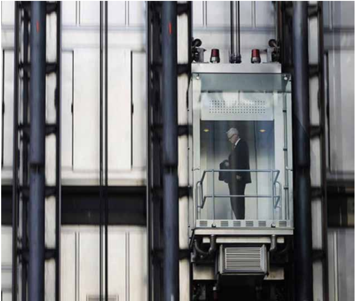
Uno de los ascensores externos en el edificio Lloyds de Londres por Richard Rogers.
