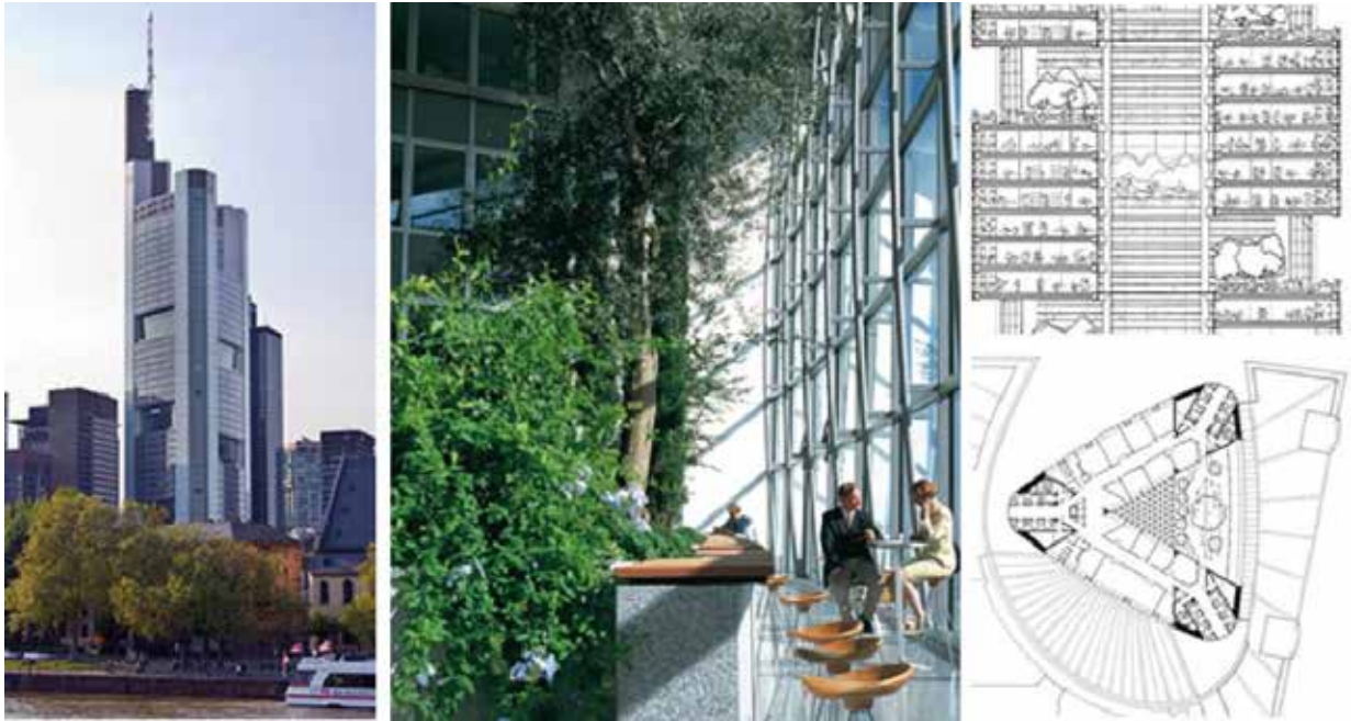
Edificio Commerzbank en Fráncfort del Meno de Norman Foster
