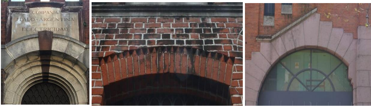
Fig. 15 Subestación Nro. 23 – Villafañe 1247/ 1247 Villafañe St. #23 power substation (foto/photo: Alan Jones y Christopher Jones – 2017)
