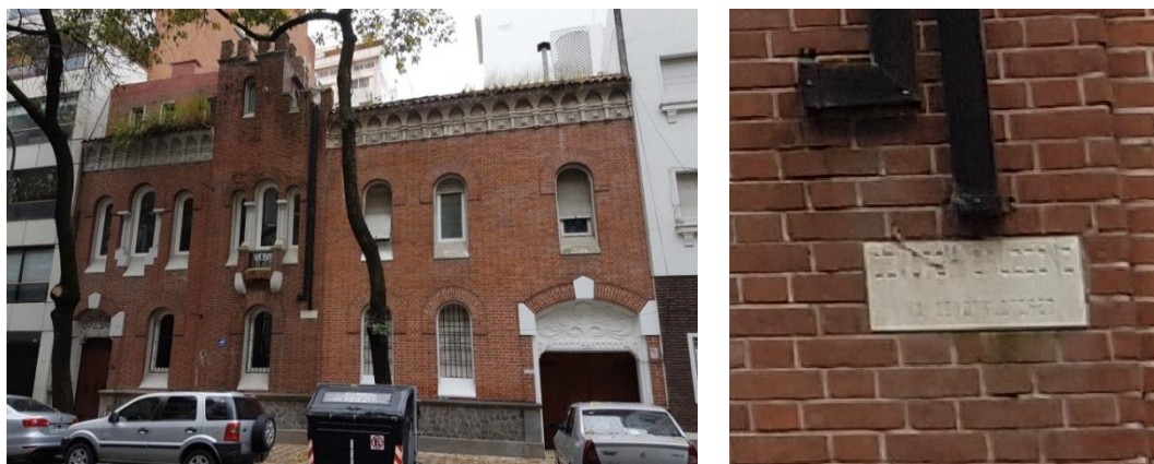
Fig. 24 y 25 Edificio en la calle Vuelta de Obligado 1121-31/ 1121-31 Vuelta de Obligado St. building (fotos/photos: Fernando Couturier – 2019)
