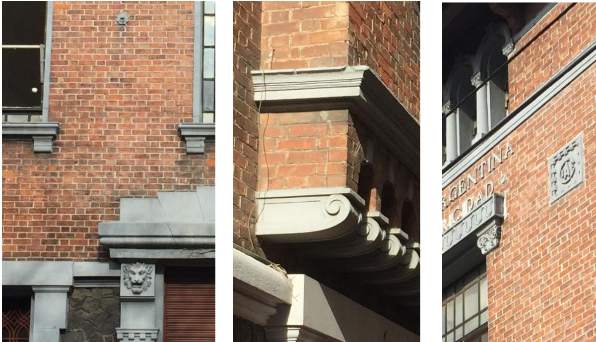
Fig. 6, 7 & 8 Subestación San Antonio 1075/79 / 1075/79 San Antonio St. substation (foto/photo: Alan Jones – 2017)
