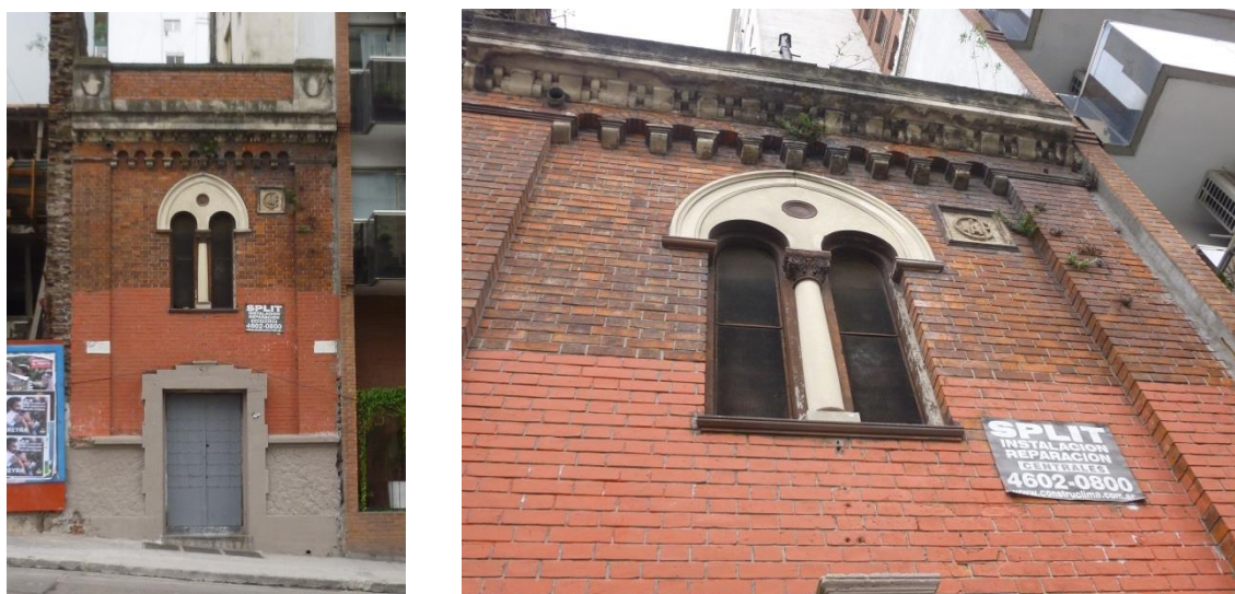
Fig. 11, 12 Subestación transformadora: San Juan 219 / 219 San Juan Av. transformer substations (foto/photo: Stella Maris Casal – 2017)
