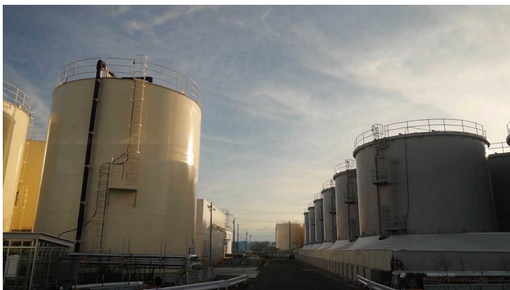
Tanques de almacenamiento de agua Fukushima Daiichi. Créditos a Joe Moross
