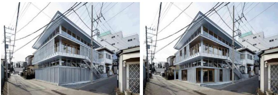
Paneles móviles de la fachada del edificio Substrate Factory Ayase de Aki Hamada Architects.
